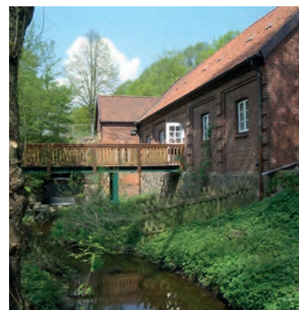
Die Gliner Mühle wurde 1229 erstmals urkundlich erwähnt
