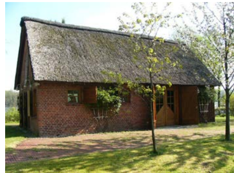
„Hütte am See“ der Sparkassen-Kulturstiftung in Grabau
